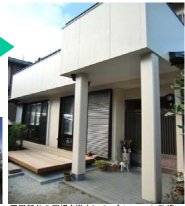
平屋部分の屋根を撤去して、バルコニーに改造
